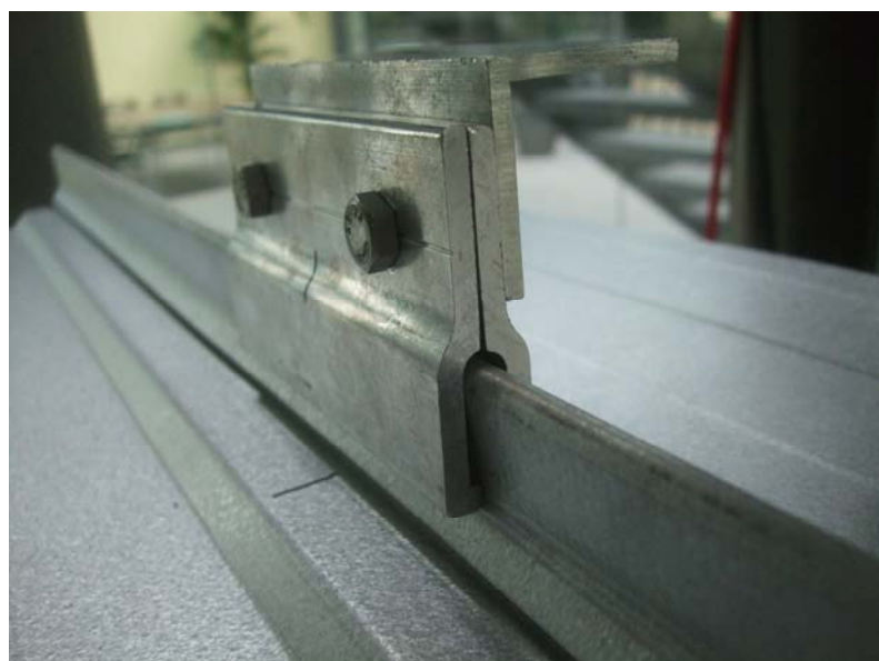
Bild 3 Stehfalzklemme montiert
