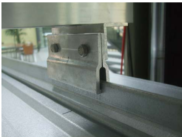
Bild 5 Verschiebung der Blechfalzklemmen
