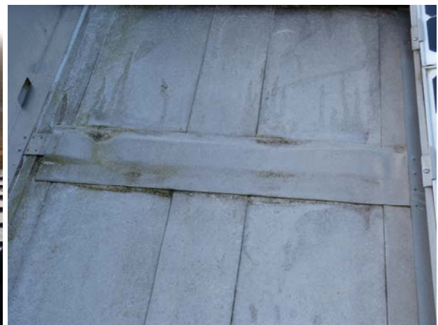
Bild 5 Klebelaschen über Verbindungsblechen
