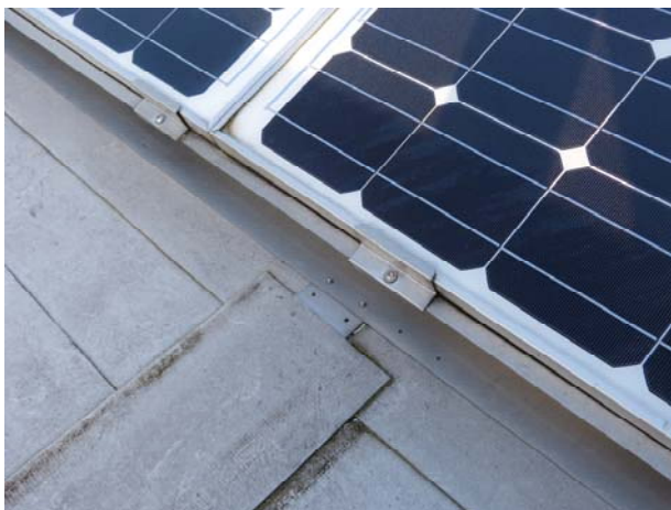
Bild 1 Fixierung mit Klebelaschen auf Folie
