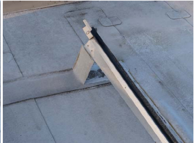
Bild 9 Versagen durch Reißen der Klebelasche
