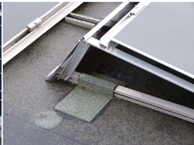
Bild 2 Fixierung mit geschweißten Laschen auf Bitumen
